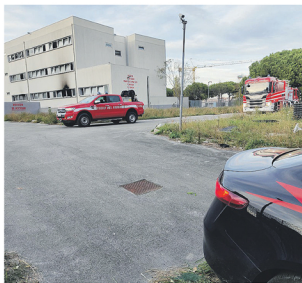
Vigili del fuoco e carabinieri davanti all'edificio di via Ugo Bassi
