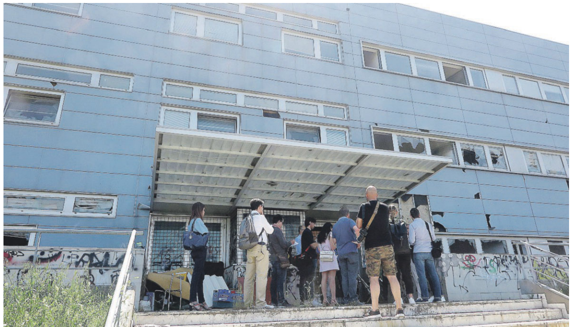
L'edificio in via Bassi che doveva ospitare la questura e ora sarà oggetto di una maxi riqualificazione
